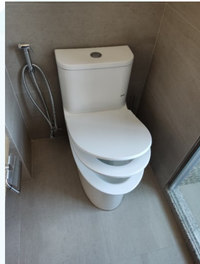
Instalación de artefactos sanitarios con certificación de bajo consumo de agua
